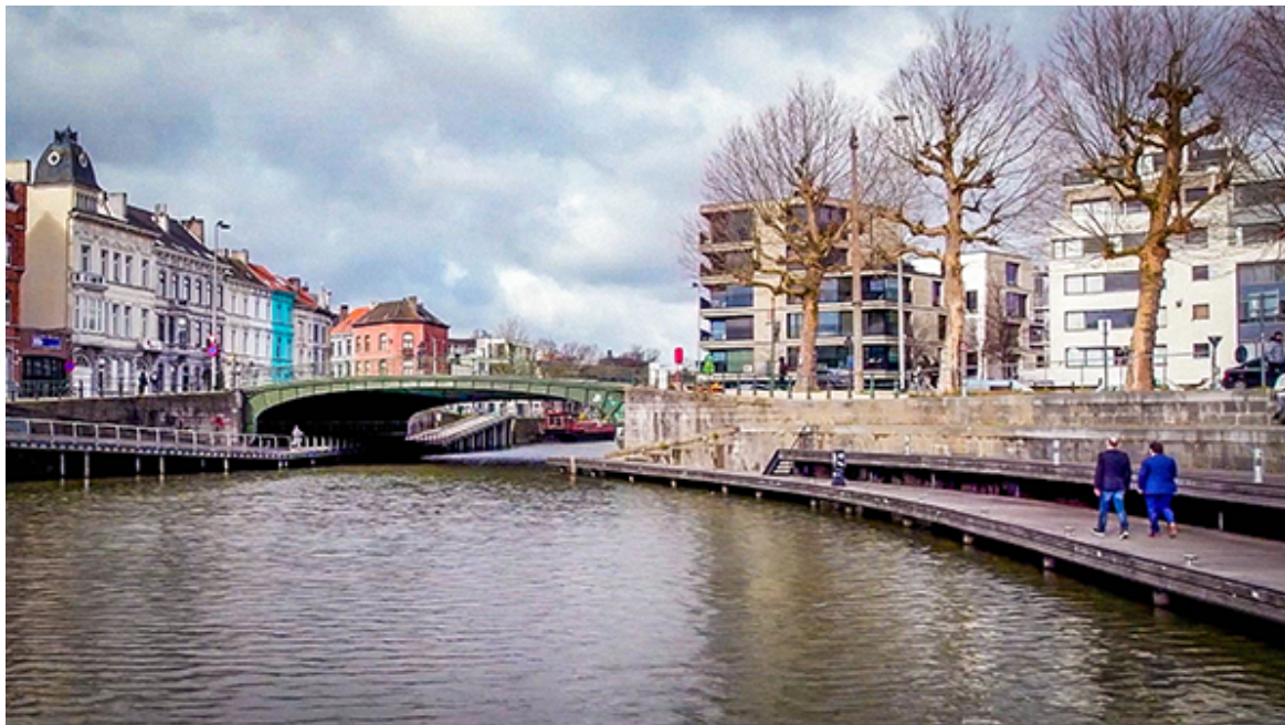
De Contributiebrug bij de toegang tot de stad Gent (België)
