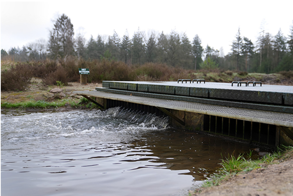
Innamegebied voor de infiltratie in het infiltratiegebied Koekenberg, in de buurt van de Ossenweg in Epe (Nederland)
