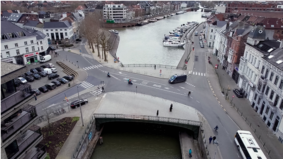
De Contributiebrug bij de toegang tot de stad Gent (België) in vogelvlucht
